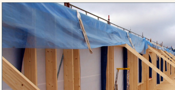
Eksempel på provisorisk beskyttelse mot fuktinntrenging.
