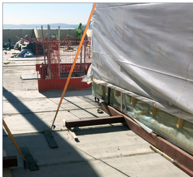
Eksempel på sikrede elementer ved lagring.
