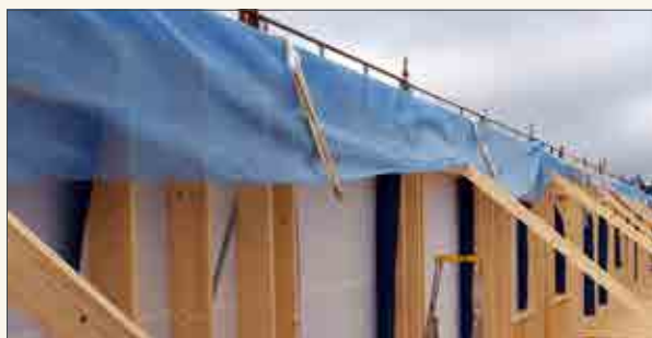
Eksempel på provisorisk beskyttelse mot fuktinntrenging.
