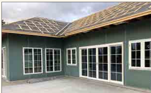
Eksempel på vegg komplettert med teip/vindsperre.
