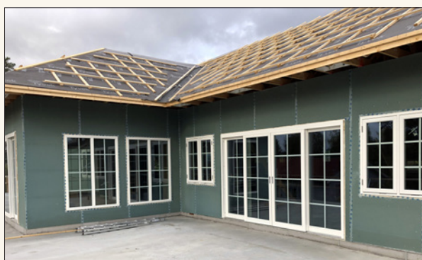
Eksempel på vegg komplettert med teip/vindsperre.
