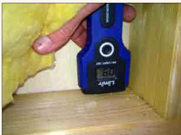
Eksempel på fuktmåling.
