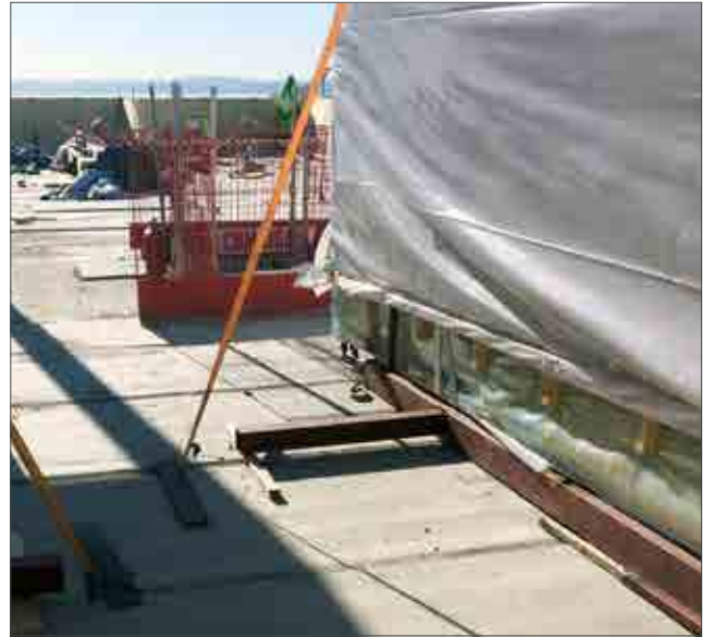
Eksempel på sikrede elementer ved lagring.
