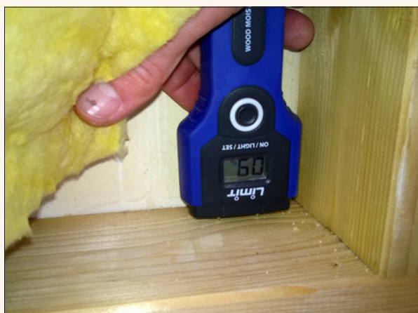
Eksempel på fuktmåling.
