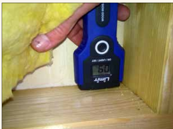
Eksempel på fuktmåling.
