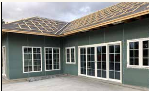
Eksempel på vegg komplettert med teip/vindsperre.
