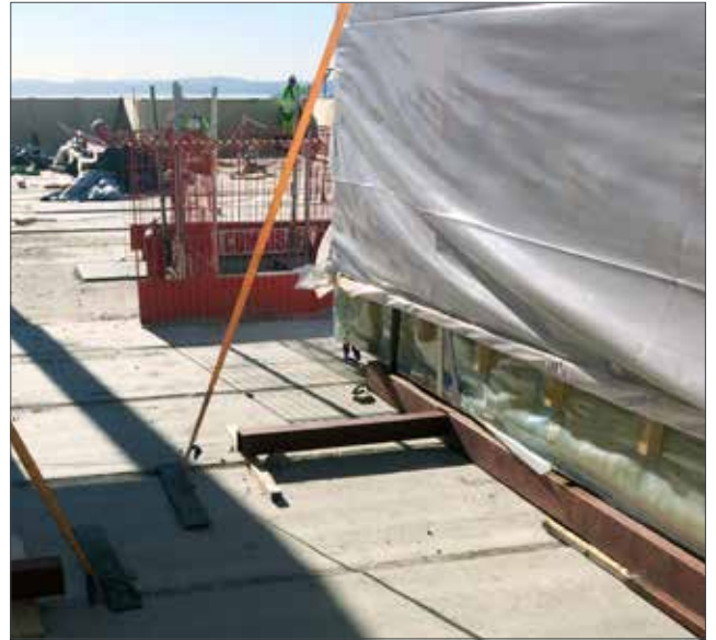
Eksempel på sikrede elementer ved lagring.
