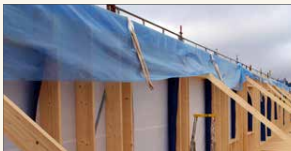
Eksempel på provisorisk beskyttelse mot fuktinntrenging.
